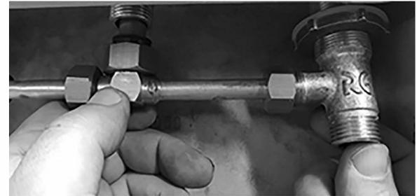
8. TOME LAS MEDIDAS DE INSTALACIÓN PARA LA "T" DE UNIÓN, Y CONECTELA A LOS EXTREMOS DE LOS LATERALES. ES POSIBLE QUE HAYA QUE DOBLAR O RECORTAR LA T PARA UNA CORRECTA INSTALACIÓN.
